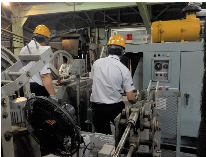
予備原動機の巻き上げを行う様子
