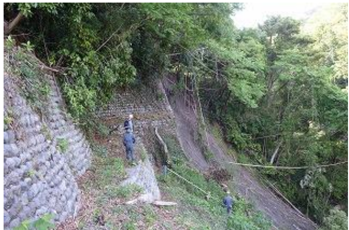
2号柱付近調査の様子
